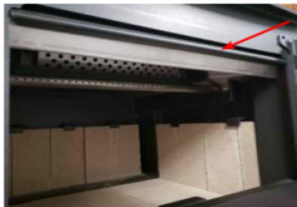
**3. Mauvaise installation :** le rebord de retour du déflecteur de fumée se trouve sous le système de nettoyage de la vitre.
